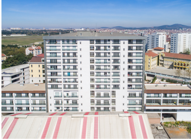
Proje Adı | Danış Park Uygulama | Cephe Giydirme ve Alüminyum Doğrama
