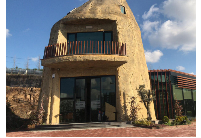
Proje Adı | Rem Yapı - Kapodokya Satış Ofisi Uygulama | Korkuluk ve Slikon Cephe
