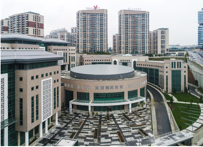
Proje Adı | Bezmialem Vakıf Üniversitesi Projesi Uygulama | Titanyum Çinko Kenet, Çatı Kaplama
