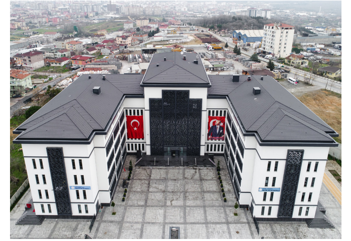
Proje Adı | Ertuğrul Gazi İmam Hatip Orta Okulu Uygulama | Cephe Giydirme
